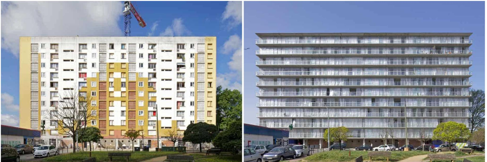
フランス・ボルドーのグラン・パーク公営住宅の断熱改修(左改修前、右改修後)
