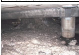
貯雪状況(雪冷熱利用時)
