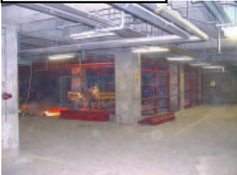
壁鉄骨下地組全景
