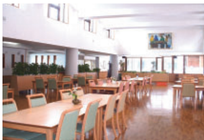
雪冷房導入スペース
