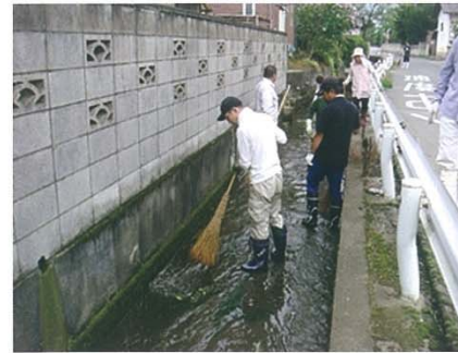
住宅地を流れるのでコンクリート護岸になっていますが、魚類などの生息を助けようと、水路清掃に当たり、ところどころ水草を残しています。(写真左)やがて草が伸びると、多くの魚が潜むようになります。(写真右)(立木上地区)2010年
