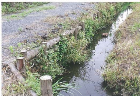
環境に配慮して木でつくられた土水路の護岸(東黒田地区)2010年
