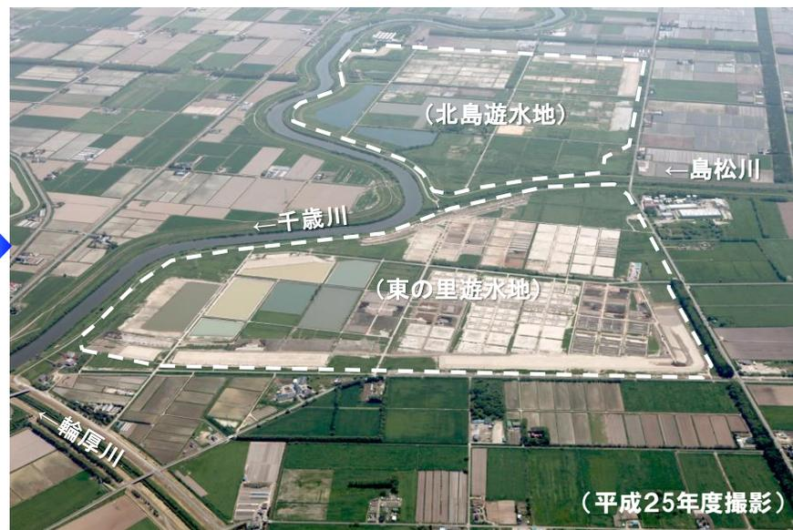
遊水地内の土砂を利用するなどして、周囲堤の盛土実施中(東の里:H24~、北島:H23~)
