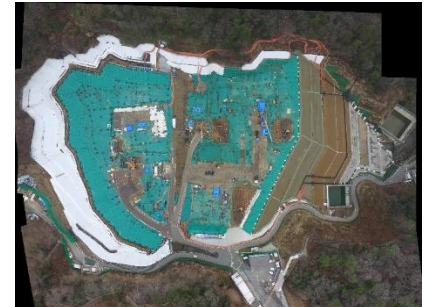
特定廃棄物埋立処分施設の様子
